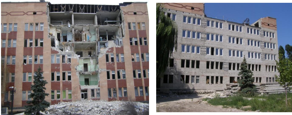
Рисунок 4.15 — Общий вид разрушенного и реконструированного здания больницы
